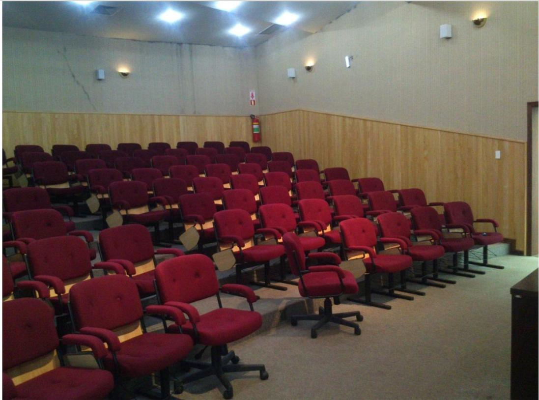
**Foto 02** - Auditório. Gesso do forro comprometido nas suas laterais, na junção com a forração da parede.
